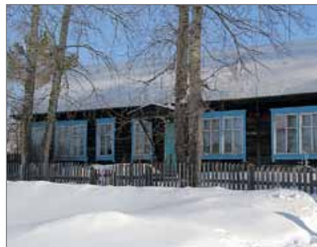
Спальный корпус Майкорской коррекционной школы Юсьвинского района
